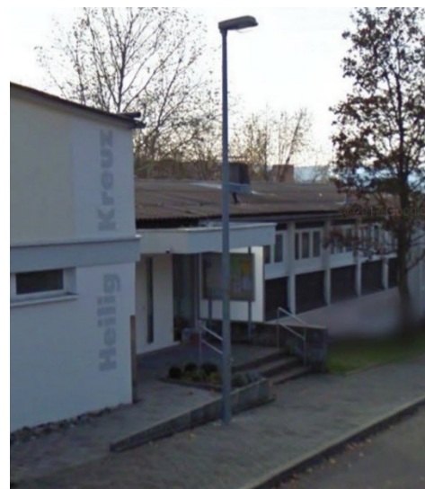
KiTa / Gemeindehaus Eingangsbereich
